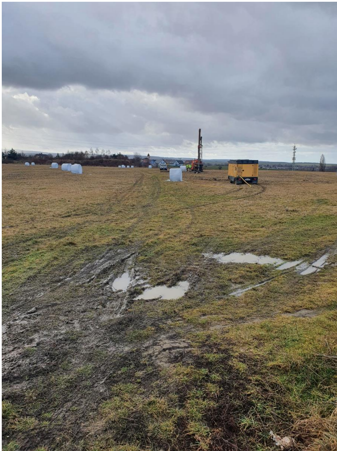
Obr. č. 2: Vrtná souprava při práci
