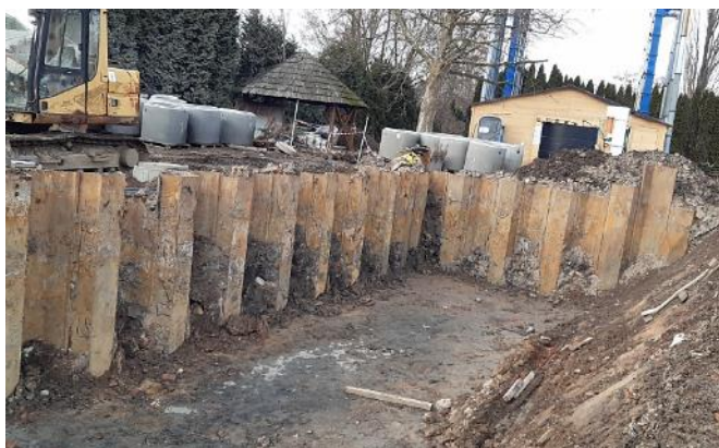
Štětová stěna před realizací kotev
