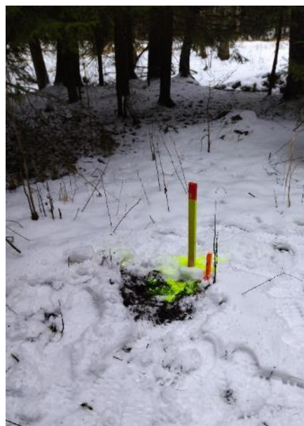
Vytyčení pozice vrtu GS-2
