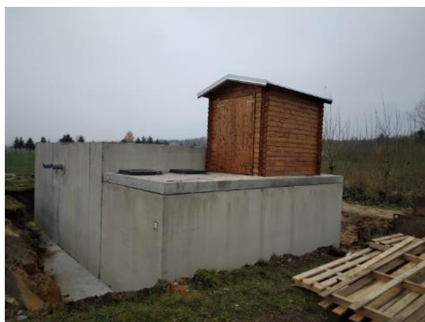
Obr. vlevo a nahoře: Výstavba ČOV Bílé Vchýnice pro 2 x100 EO
