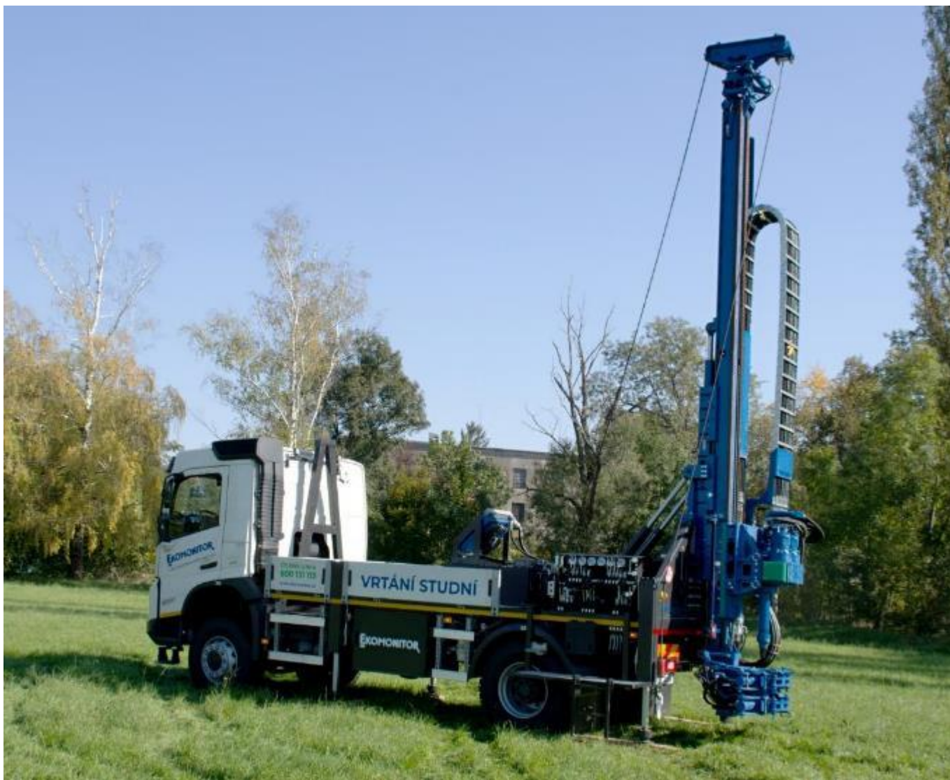
Souprava BRT Volvo připravená k vrtání
