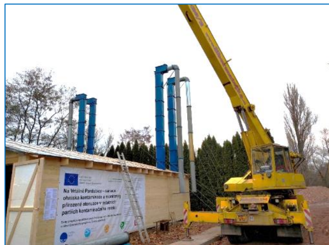
Výstavba dekontaminační stanice
