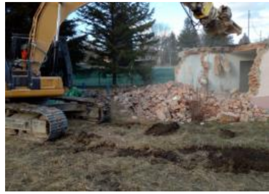
Obr. č. 5: Asanácia stavebných objektov
