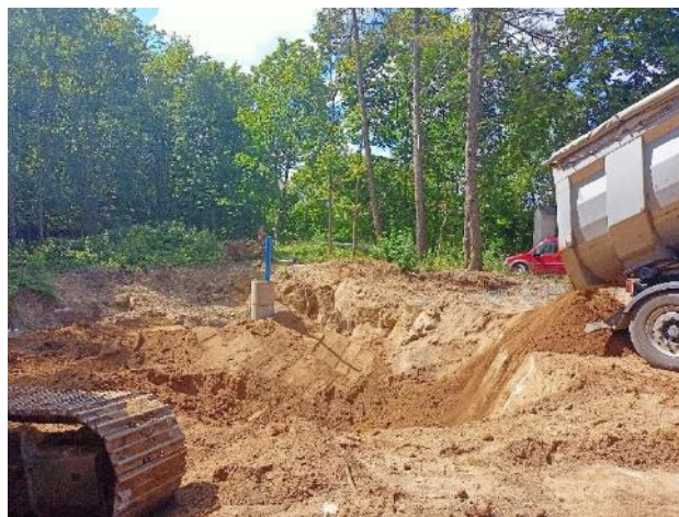
Zpětný zásyp zeminou
